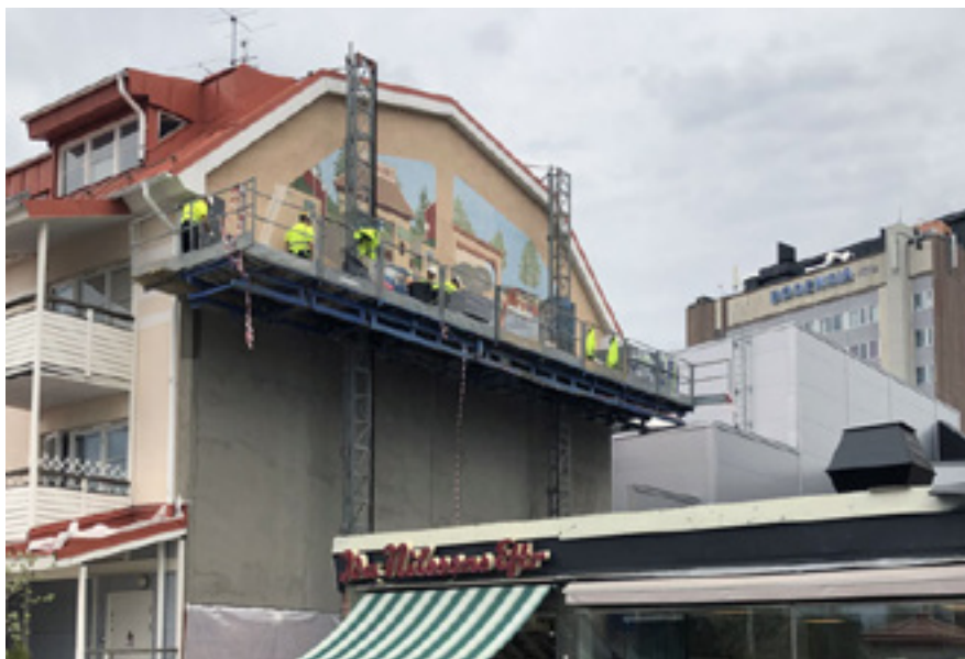
Fasadputs på Färgaregatan 10.
